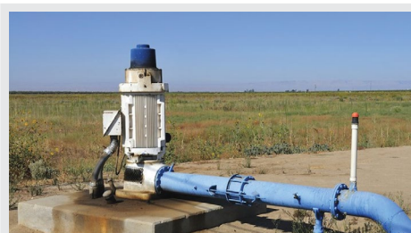
Скважины и колодцы
